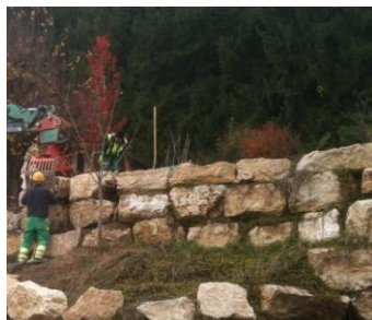
Enrochement de type cyclopéen
