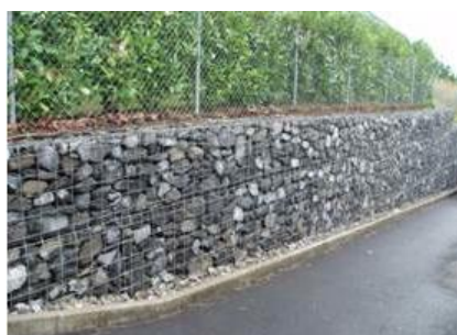
Muret en gabion
