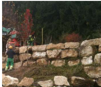
Enrochement de type cyclopéen
