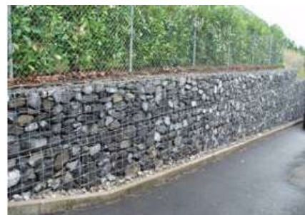
Muret en gabion
